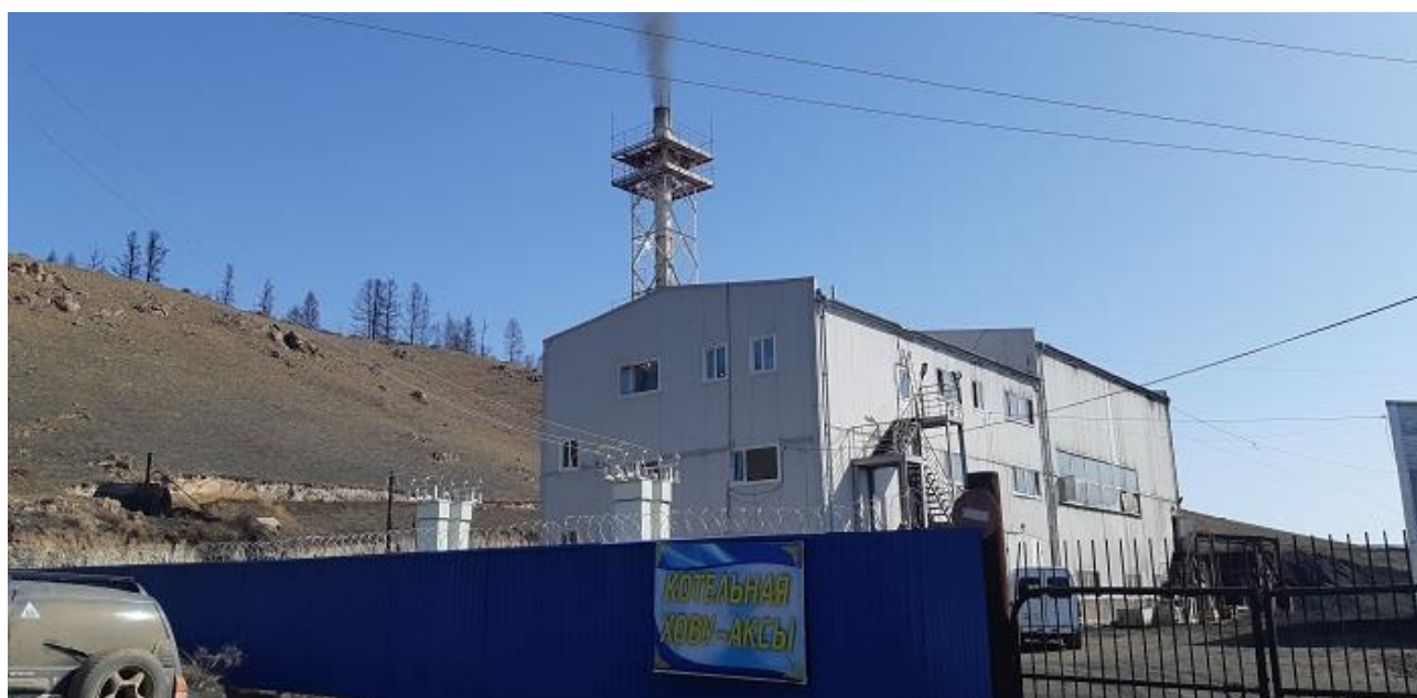
Рисунок 3. Общий вид котельной с. Хову-Аксы
